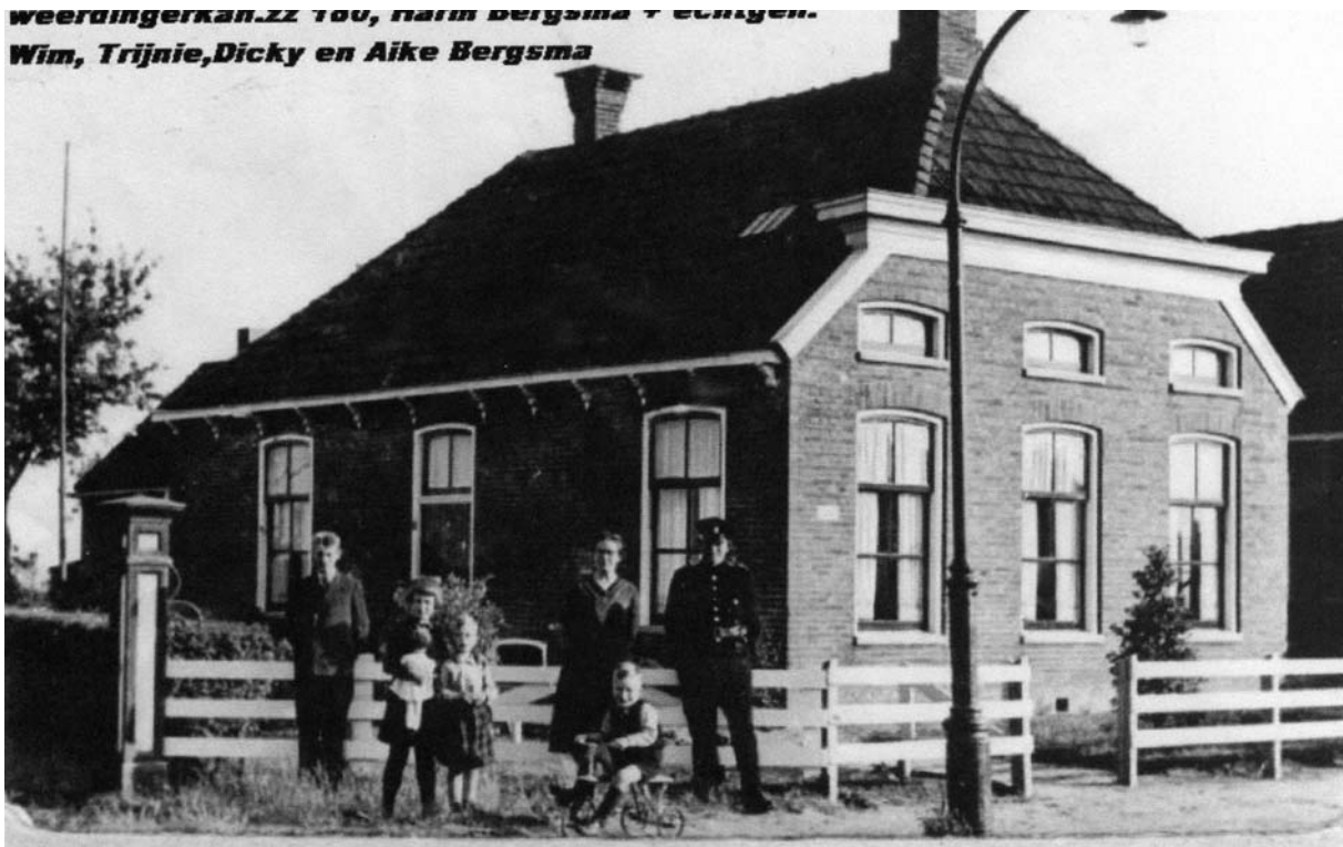
Veldwachterswoning aan het Weerdingerkanaal z.z., rechts van oprijlaan naar kerk of.)
